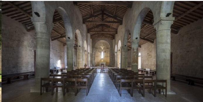
Interno della Chiesa di Cellole
